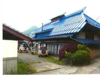
▲新ストーブの煙突が屋根に出ている。給湯のみ、ソーラー温水器を利用。「家を持つと、地域密着の生活になりますね。草刈り、道路愛護、用水路の掃除など、班活動にも参加します」。
